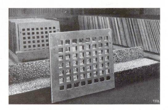
Siedlung in Drancy. Montagefertige Balkonbrüstungs- und Aussenwandelemente in Eisenbeton (geölte Metallschalungen)
