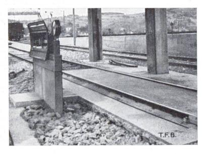
Abb. 2 Brückenwaage aus Eisenbeton
