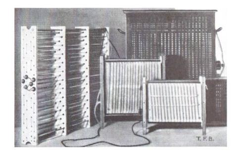
Abb. 5 Träger für Heizwiderstände
