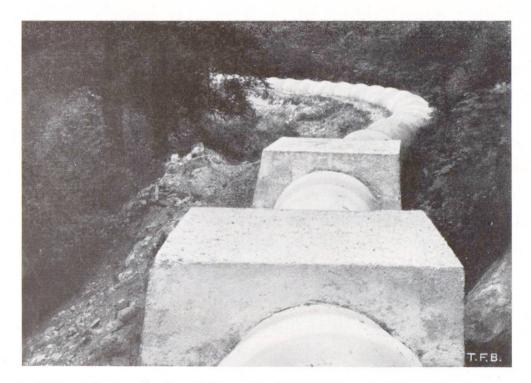
Abb. 5 Schleuderbetonrohr-Druckleitung für Elektrizitätswerk, 125 cm Durchmesser, 4 Atü
