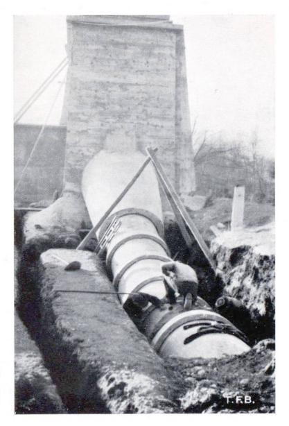
Abb. 2 Anschluss einer Druckleitung an Wasserschloss, 125 cm Durchmesser
