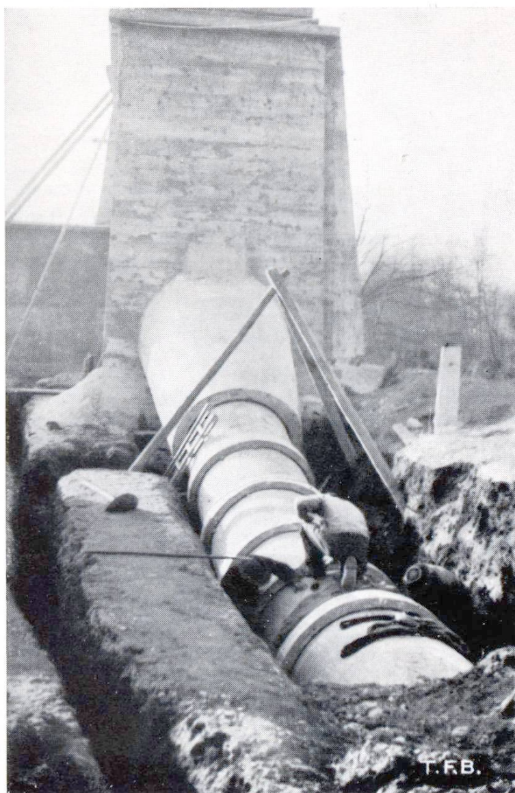
Abb. 2 Anschluss einer Druckleitung an Wasserschloss, 125 cm Durchmesser
