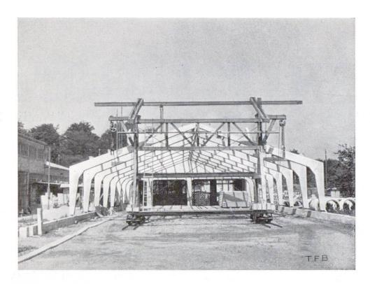
Abb. 1 Montage der Eisenbetonbinder. Im Vordergrund Montagekran
