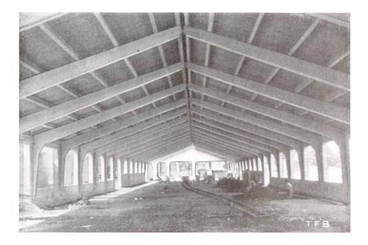
Abb. 3 Dachuntersicht nach der Eindeckung mit Welleternit
