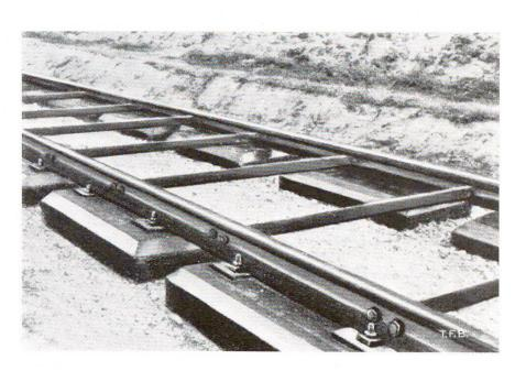
Abb. 3 Fertig verlegter, noch nicht eingedeckter Oberbau auf Betonlängsschwellen, System Otzen. Aus "Zement" 1940, Heft 15
