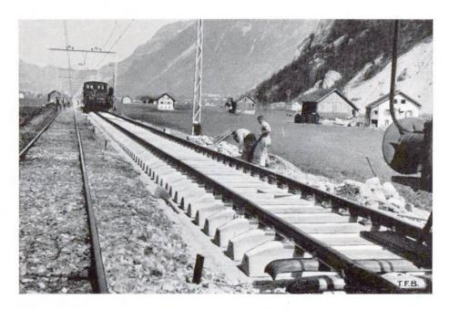
Abb. 6 Grössere Versuchsstrecke in Hauptgeleise. Linienführung gerade (Nr. 6213 BRB. 3. 10. 39.)
