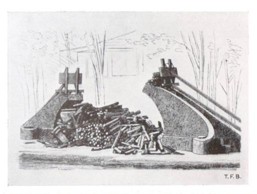
Abb. 6 Betonbrücke an der Landesausstellung 1883 nach der Probebelastung bis zum Einsturz (Nachgeben der Widerlager)
