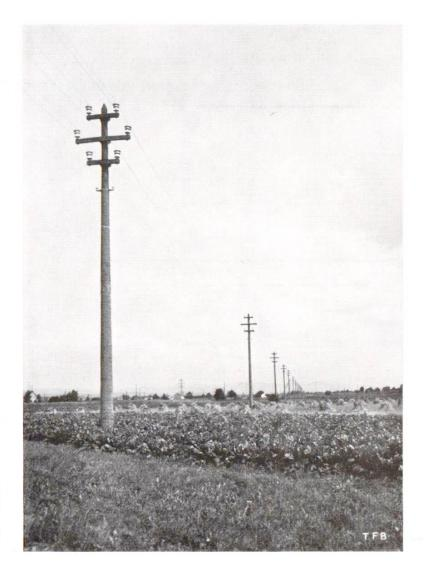
Abb. 1 Teil der Albulaleitung der Stadt Zürich erstellt 1907 in Eisenbetonmasten. Das Bild zeigt als Beispiel hohle Rundmasten.
