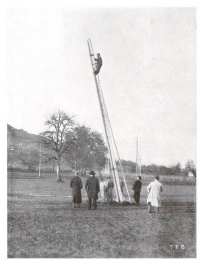
Abb. 2 Mast der Albulaleitung mit H-förmigem Querschnitt beim Umreissversuch nach 32-jährigem Gebrauch.
