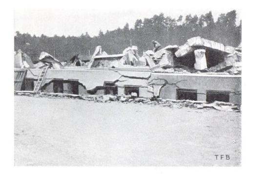
Abb. 5 Abbruch eines Fabrikgebäudes durch Sprengung. (nach E. Stettler, s. Lit.).
