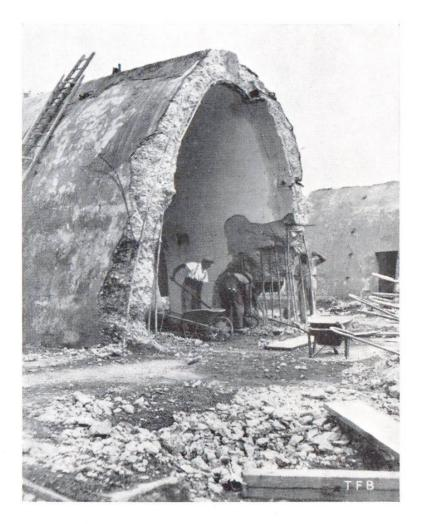
Abb. 4 Abbruch eines armierten Betongewölbes mittelst Abbauhämmern.
