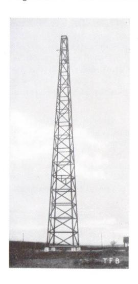
Abb. 3 Fachwerkturm aus vorgespannten Eisenbetonsäulen. (Aus "Beton und Eisen", 1940, Heft 11 und 12)
