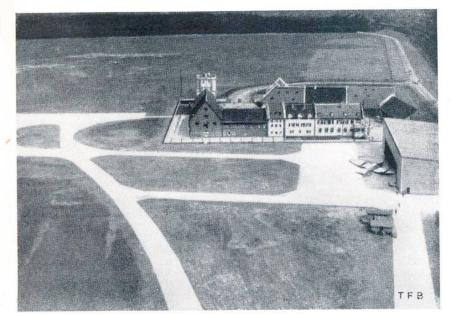
Anroll- und Startbahnen im Flughafen Frankfurt a. M. Auf Unterbeton verlegte Betonplatten, Ausmass ca. 10'000 m<sup>2</sup>
