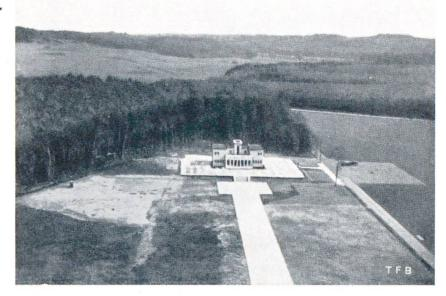
Startbahn des Flugplatzes Giessen, 200 m lang und 10 m breit, mit auf Unterbeton verlegten Betonplatten
