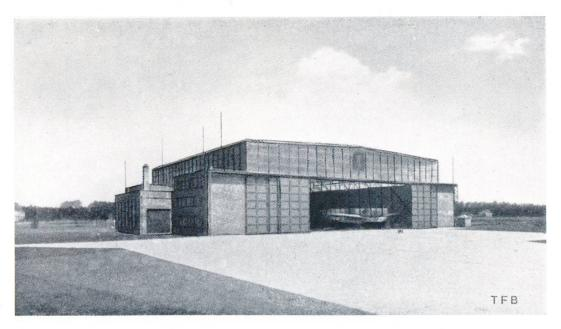
Abb. 4 Zweischichtige Beton-Rollfläche vor der Halle des Flughafens Lübeck-Travemünde.
