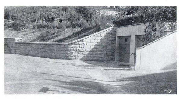
Abb. 8 Stütsmauer und Garteneinfassung aus Naturstein und Beton
