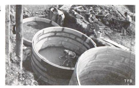
Fig. 4 **Silobatterie im Bau** Silobau Luzern, Werchlaube
