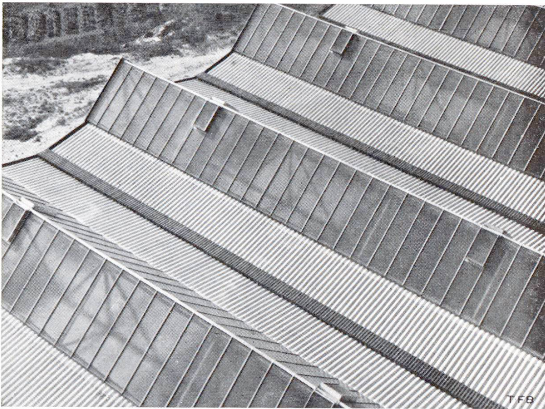
Fig. 6 Hallenbedachung in Welleternit und Glas.
