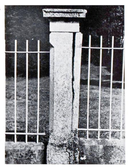
Fig. 2 Natursteinsockel, infolge Temperaturverkürzung des eisernen Geländers entlang der natürlichen Schichtung zerrissen.
