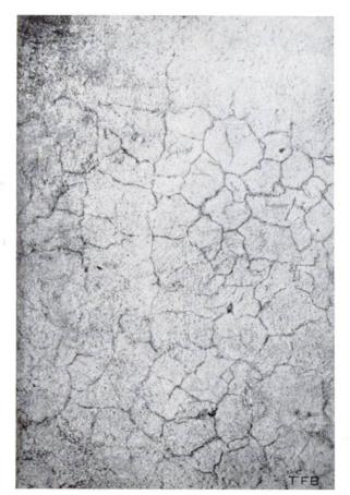
Schwindrisse in Verputz, der mit einem Übermass an feinem Sand hergestellt wurde und ausserdem vorzeitig ausgetrocknet ist (Haarrisse).
