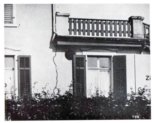
Fig. 1 Setzungsriss zwischen bestehendem Gebäude und Anbau.
