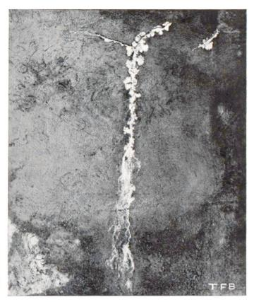
Fig. 2 Setzungsrisse in den Seitenwänden einer Unterführung sind nach einiger Zeit unter "Selbstheilung" versintert und wieder dicht geworden.
