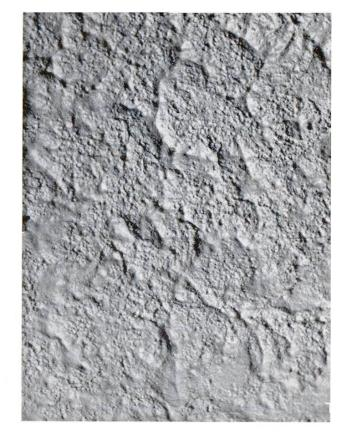
Dieser Anspritz dient erstens zur Gewährleistung einer guten Haftung zwischen Mauerwerk und eigentlichem Verputz und zweitens zur Abdichtung. Infolgedessen muss er lückenlos angetragen werden, eventuell in zwei dünnen Schichten. Er soll rauh und griffig sein.
