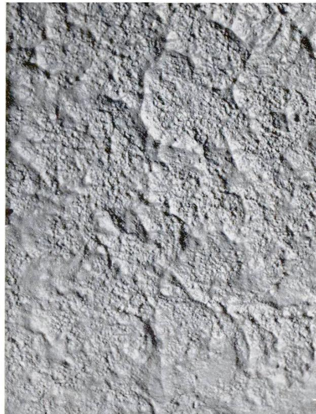
Dieser Anspritz dient erstens zur Gewährleistung einer guten Haftung zwischen Mauerwerk und eigentlichem Verputz und zweitens zur Abdichtung. Infolgedessen muss er lückenlos aufgetragen werden, eventuell in zwei dünnen Schichten. Er soll rauh und griffig sein.
