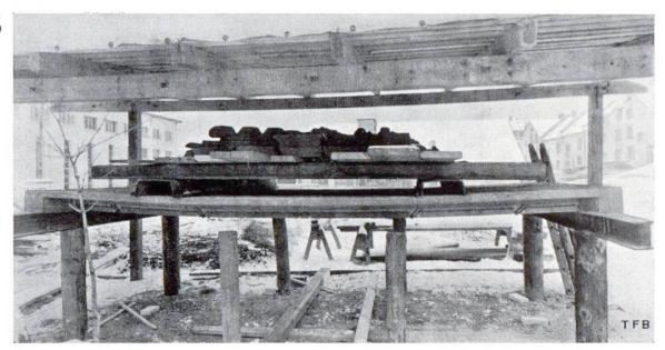
Fig. 2 **Holz-Betondecke**. Belastungsprobe vom 18./19. Dezember 1940.
