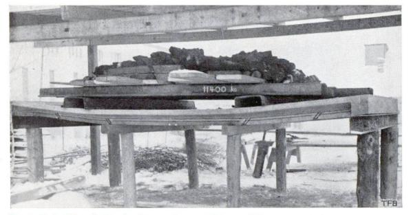
Fig. 3 **Holz-Betondecke.** Bruchversuch vom 6. Januar 1941.
