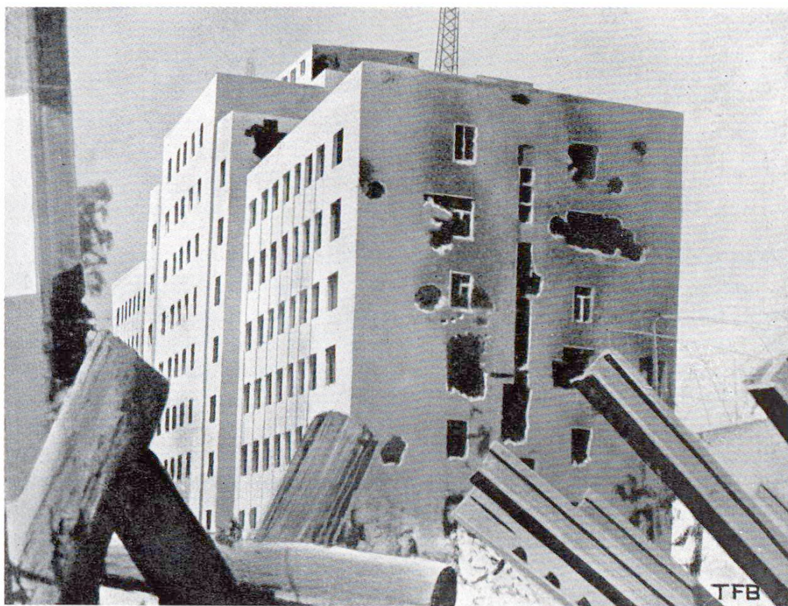
Fig. 1 Verwaltungsgebäude des Nordbahnhofs in Shanghai nach der Bombardierung.
