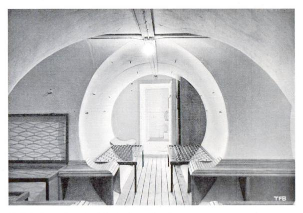
Fig. 6 Luftschutzraum aus Schleuderbetonrohren.
