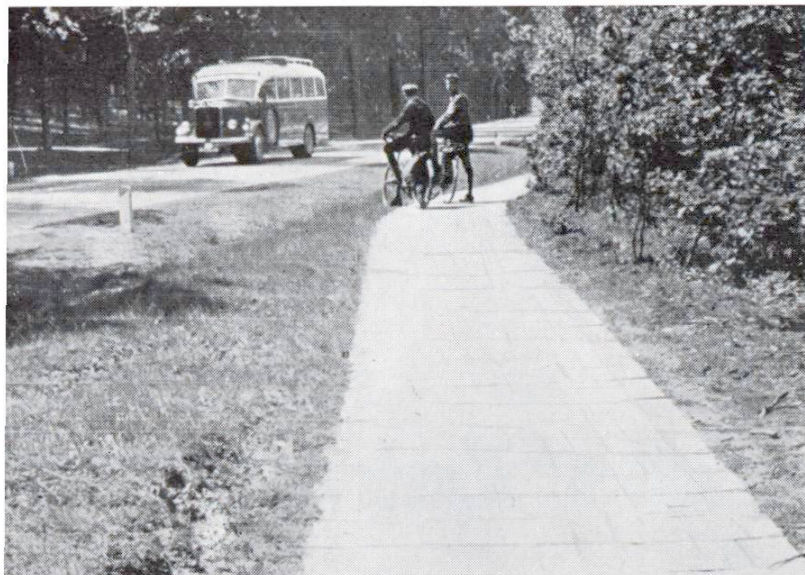
Abb 1. Holländischer Radfahrweg aus kleinen Cementplatten.
