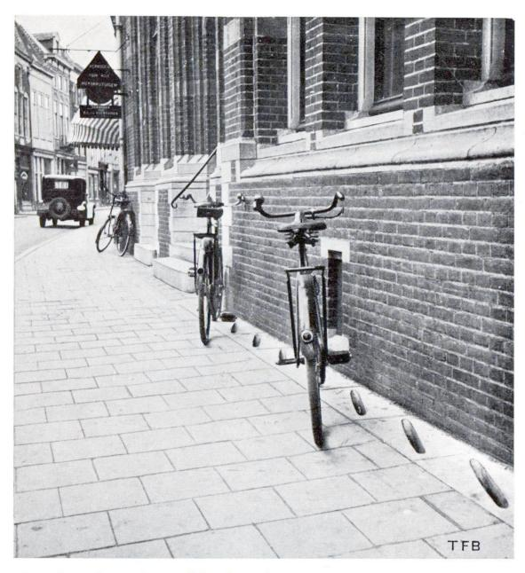
Abb. 7. Beton-Formsteine zur Fahrradgaragierung.
