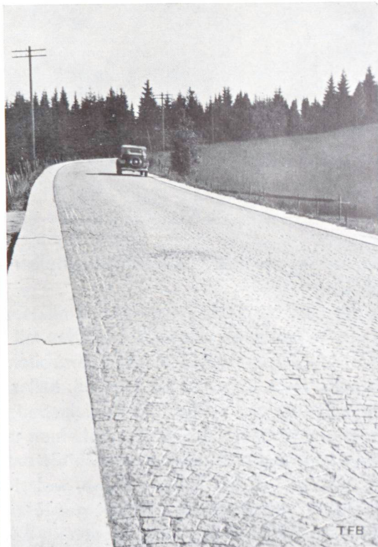
Abb. 3. Norwegischer Beton-Radfahrstreifen.
