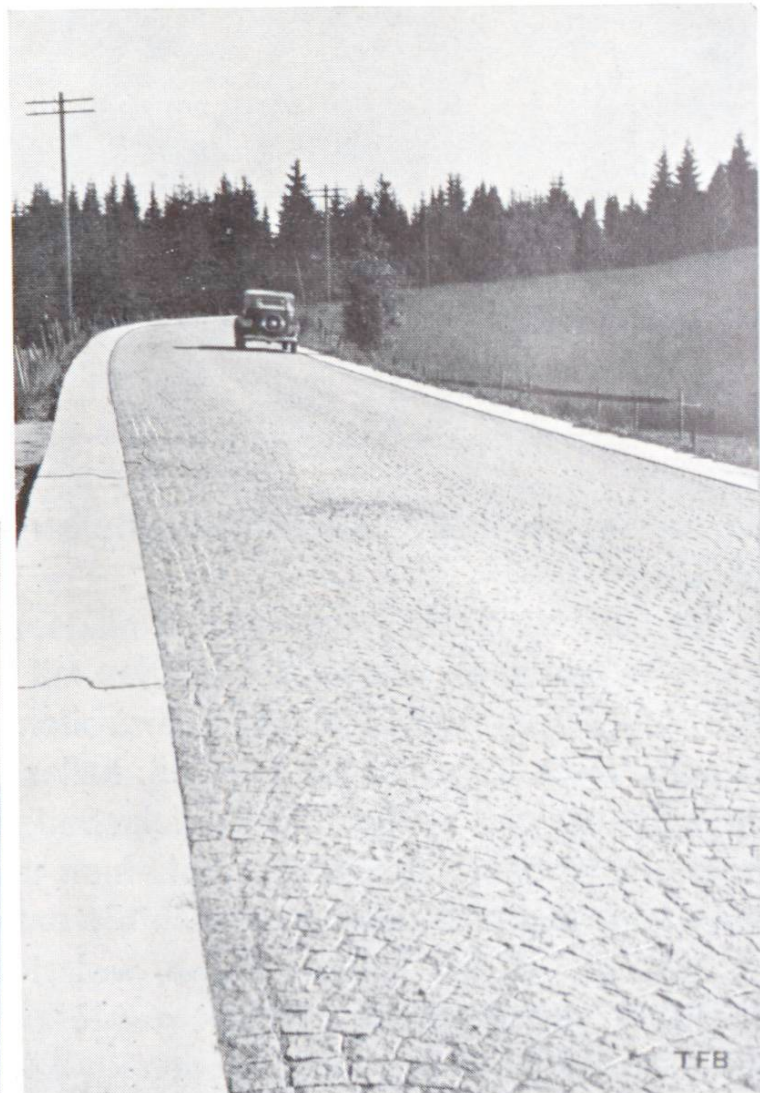
Abb. 3. Norwegischer Beton-Radfahrstreifen.
