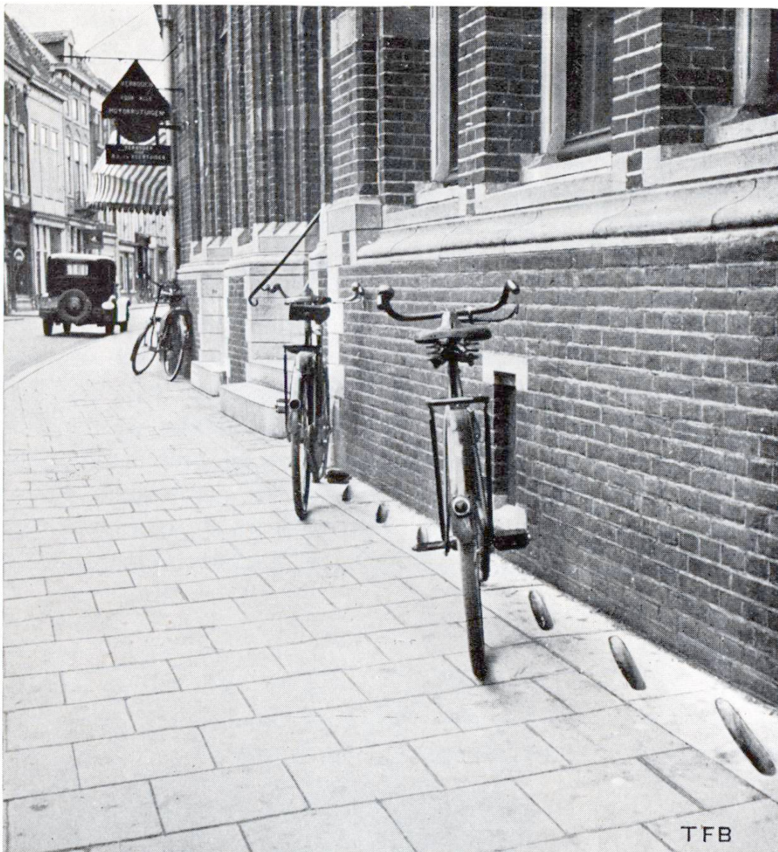
Abb. 7. Beton-Formsteine zur Fahrradgaragierung.
