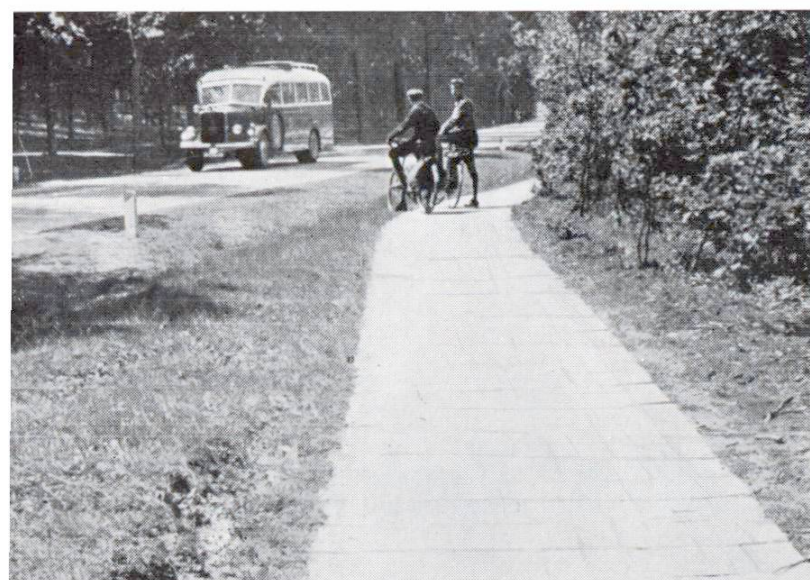
Abb. 1. Holländischer Radfahrweg aus kleinen Cementplatten.
