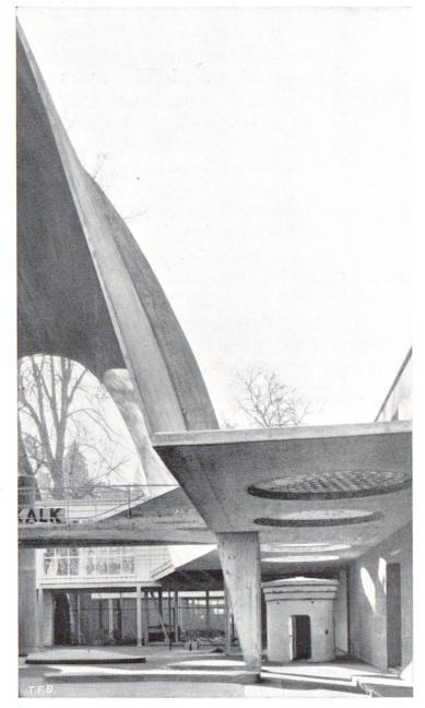
Abb. 2. **Der Träger der Cementtonne.** (Eines der beiden Beinpaare).
