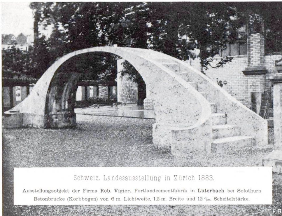
Abb. 4. Betonbrücke an der Landesausstellung 1883, die damals als Spitzenleistung der Cement- und Betontechnik gezeigt wurde
