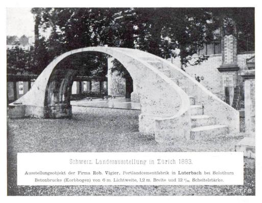
Abb. 4. Betonbrücke an der Landesausstellung 1883, die damals als Spitjenleistung der Cement- und Betontechnik gezeigt wurde
