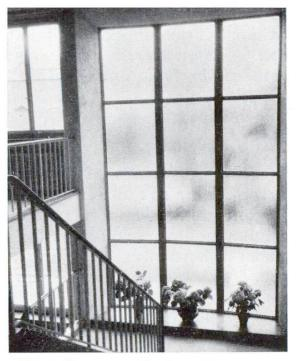
Abb. 4. Das grosse Fenster mit Betonsprossen im Treppenhaus.
