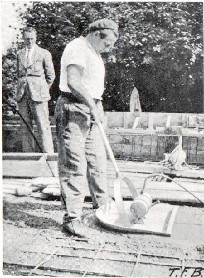
Abb. 3 Oberflächenvibration mit Vibrierschaukel
