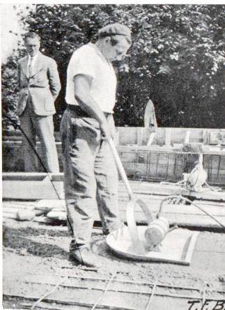
Abb. 2 **Aussenvibration** mittels der Vibriergabel und eines an der Seitenschalung befestigten Elektro-Vibrators.
