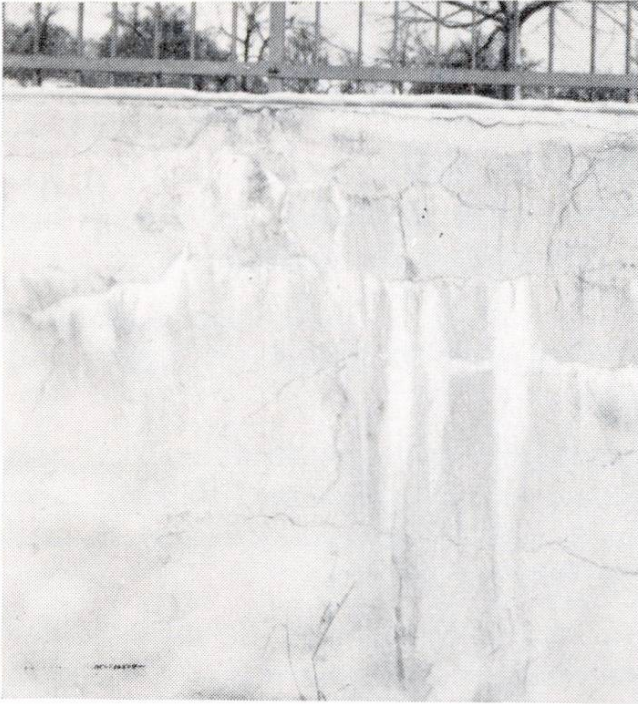
Abb. 2 Kalkausblühungen auf einer verputzten Betonstützmauer (Kalktränen längs der Putzrisse).
