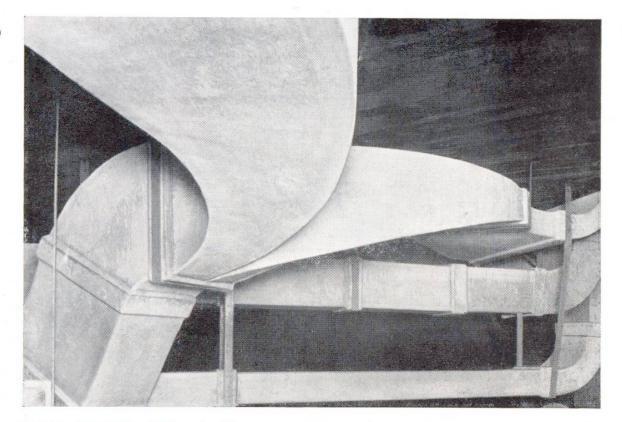
Abb. 6 Eternit-Ventilationskanäle.
