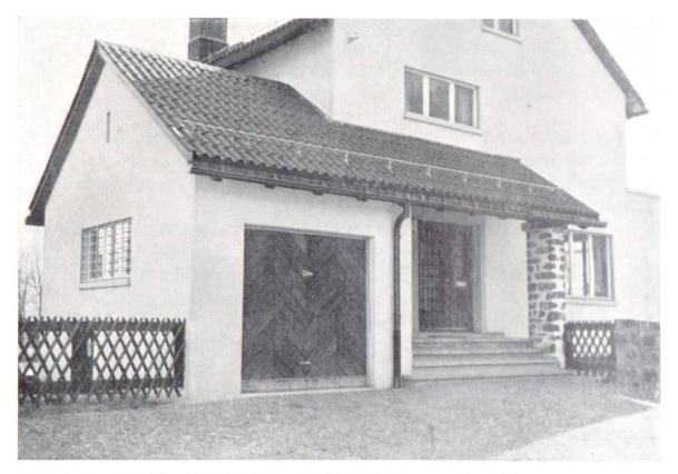
Abb. 4 Gewellte Eternit-Dachplatten. Farbe dunkelbraun, geflammt.
