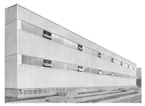
Abb. 5 Well-Eternit-Verkleidung einer Lagerhalle.
