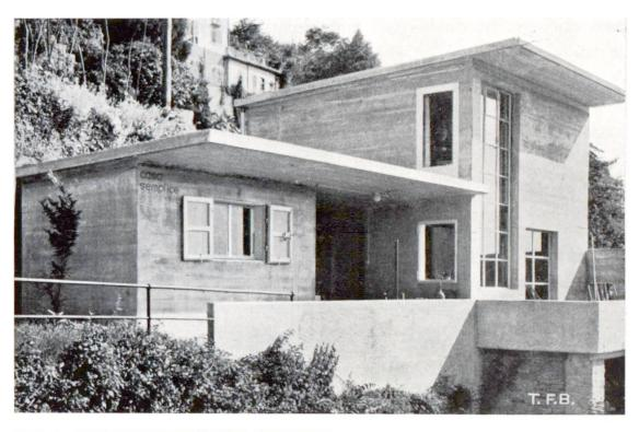
Abb. 3 Atelierhaus in isoliertem Eisenbeton Wärmedurchgangszahl der Aussenwände k = 1,0 des Flachdaches (Isocub-Decke) k = 0,6
