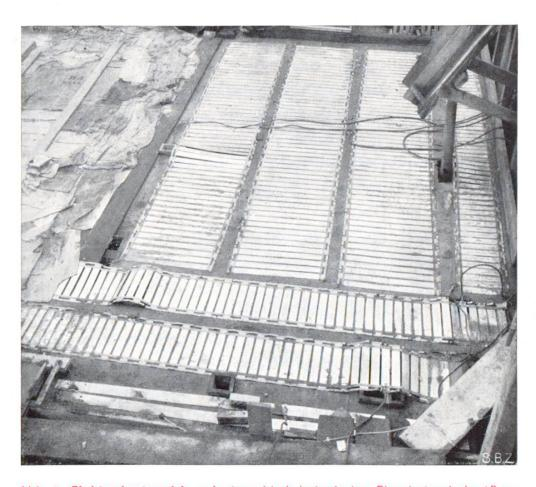
Abb. 2 **Elektrodenteppich** auf einer frisch betonierten Eisenbetondecke (Baugenossenschaft "Hirse" in Zürich).
