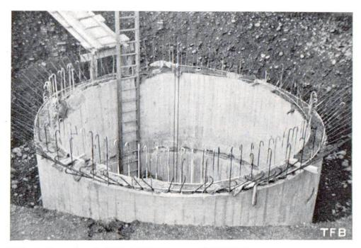
Abb. 2 Bau eines Luftschutzraumes aus Eisenbeton. System: Schindler.
