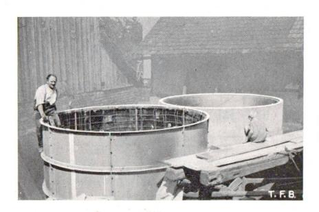
Abb. 4 Bau von 2 Grünfuttersilos aus Eisenbeton in Goldach bei St. Gallen links: transportable Stahlschalung mit angehängter Wandarmierung rechts: der fertige Eisenbetonsilo von 19 m³ Inhalt.
