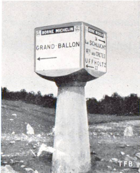
Abb. 3 Ein „Borne-Michelin“ Wegweiser aus Beton im Elsass
