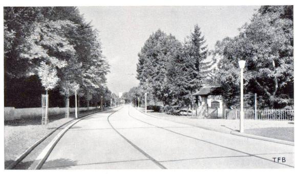
Abb. 6 **Eine mustergültige Strasse**: L'avenue des Bains in Yverdon - Betonbelag, beidseitig Cementrandsteine und Beleuchtungspfosten aus Kunststein.
