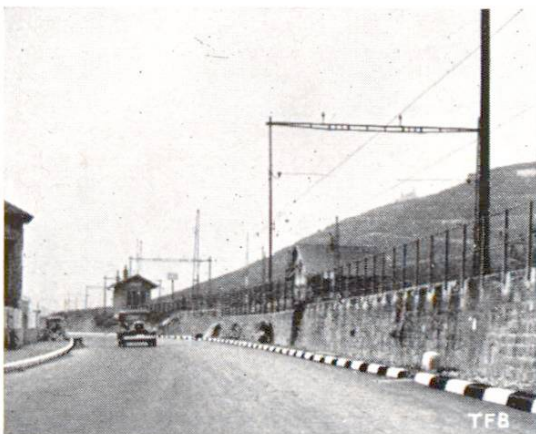
Abb. 2 Bordschwellen aus weissem und schwarzem Kunststein (Hauptstrasse Lausanne-Vevey, bei La Villette).
