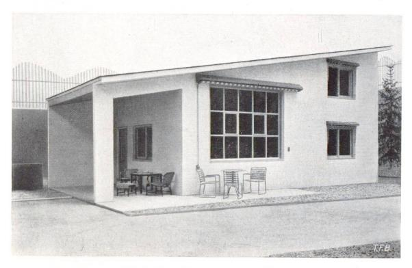
Abb. 2 Fassade aus armiertem Beton
