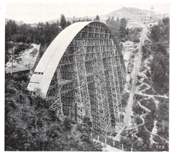
Abb. 1\* **Bau der grossen Eisenbetonbrücke auf dem Hundwilertobel** - Spannweite 105 m. Die Gesamtansicht des Lehrgerüstes und der Transportanlagen zeigt, welch gewaltige Holzmengen beim Bau von Eisenbetonkonstruktionen verbraucht werden.
