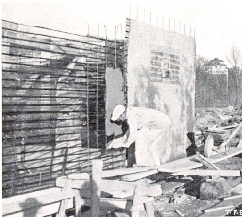
Abb. 1 Ausführung (Schwimmbad Möriken-Wildegg) Der Cementmörtel wird mit der Talosche aufgezogen; hinten eine fertig grundierte Fläche, die später noch abgerieben wird.
