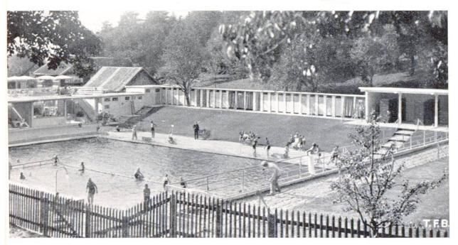
Abb. 3 **Schwimmbad Walzenhausen** (App. A.-Rh.) Decken sowie Aussen- und Zwischenwände aus Cement-Streckmetall. Tragelemente und Bassin aus Eisenbeton. Projekt und Bauleitung: Ing.-Bureau Keller, Brugg Ausführung: Bruderer & Calderara, Teufen-Walzenhausen
