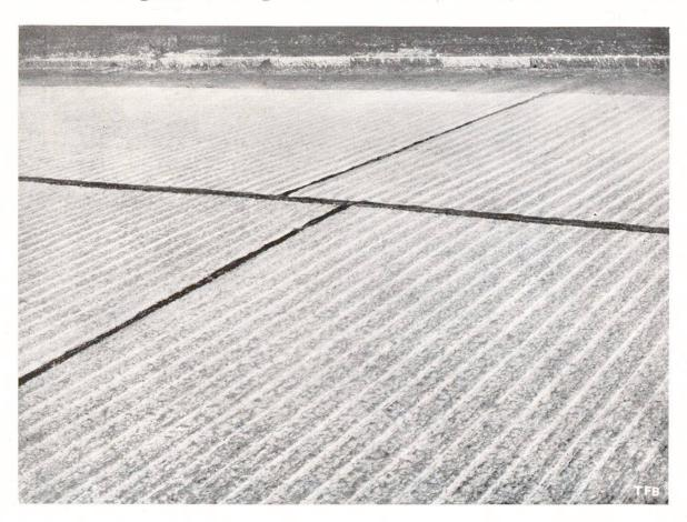
Abb. 1 Betonoberfläche mit starker Riffelung (Kreuzlingen)
