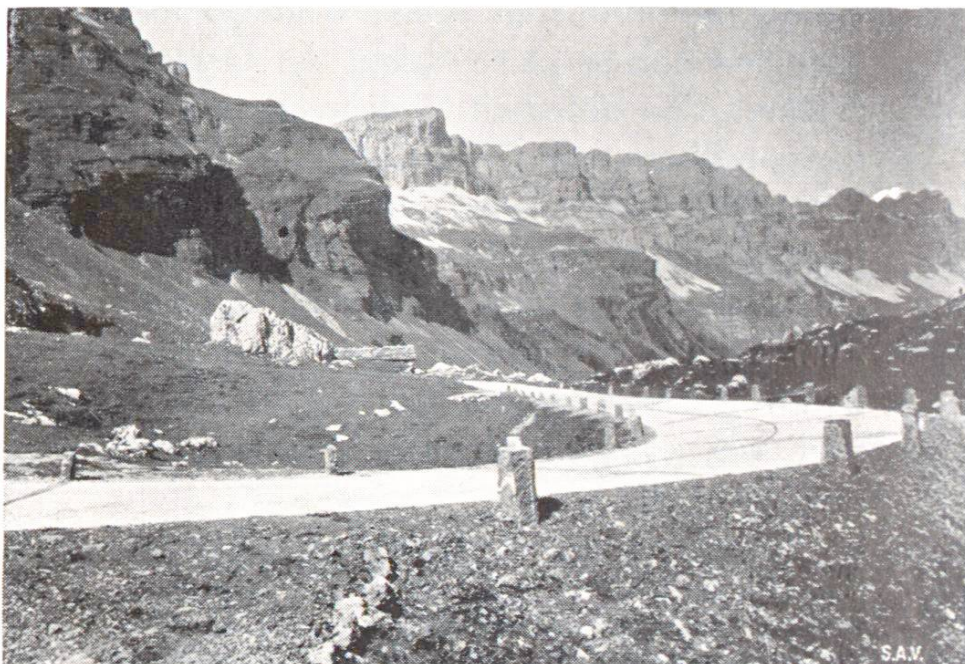
Abb. 4 Klausenpafzstrasse, «Kluskehre», 12prozentig überhöht.
