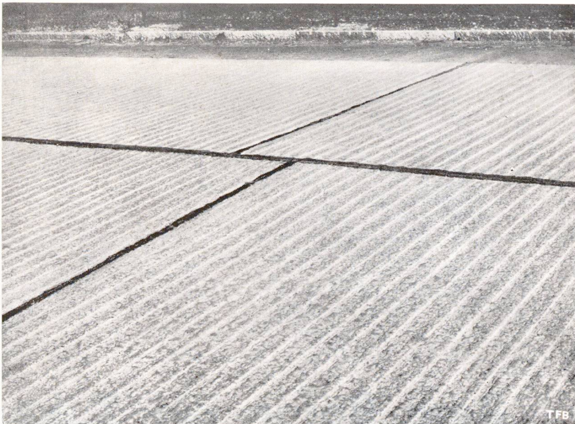
Abb. 1 Betonoberfläche mit starker Riffelung (Kreuzlingen)
