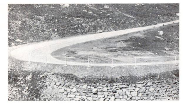
Abb. 5 Klausenpaßstrasse, «Säubodenkehre», nahe Passhöhe, 14 prozentig überhöht.
