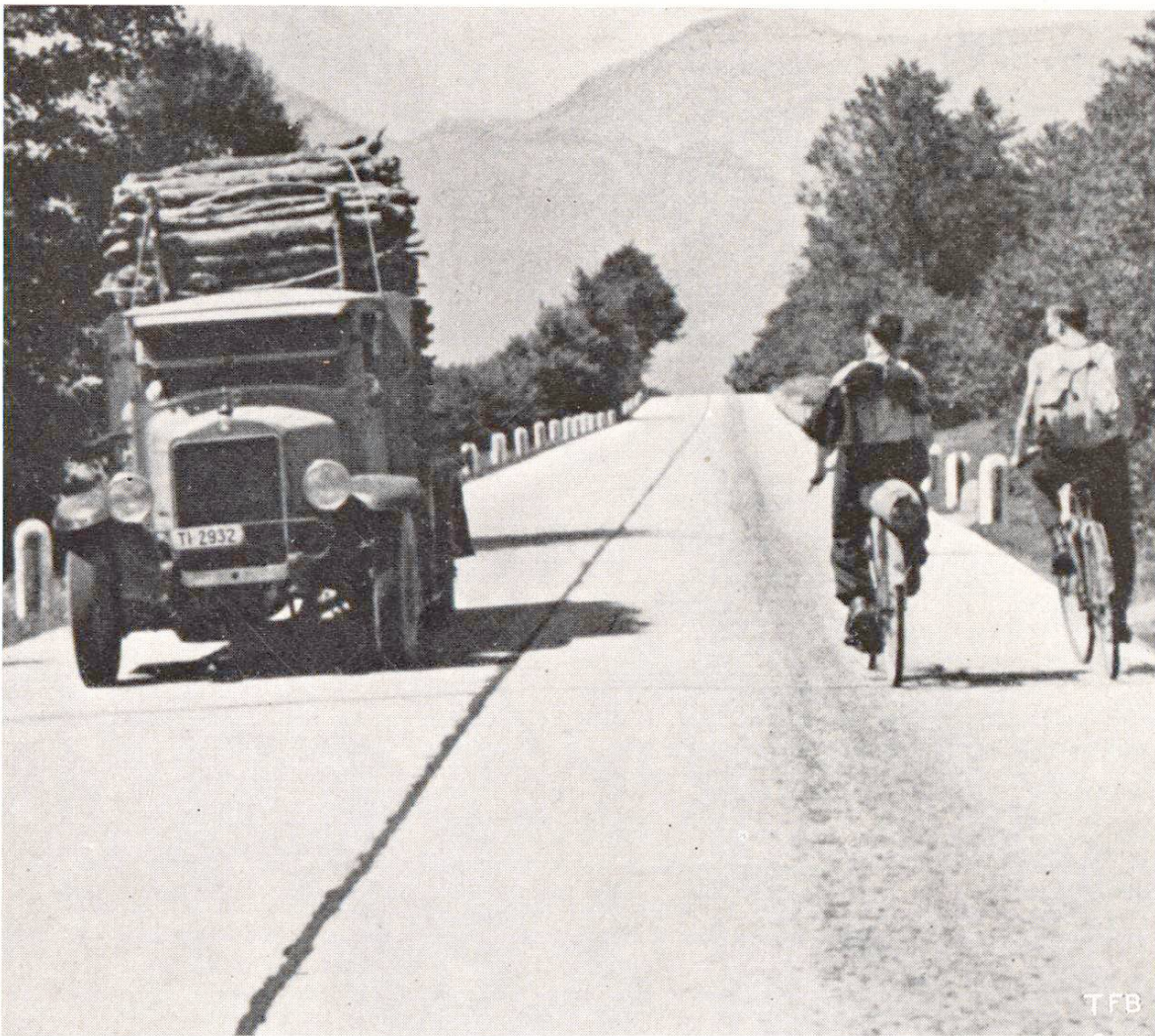
Abb. 2 Monte Ceneri (Südrampe); max. Steigung 8,9 %. Das Bild zeigt deutlich, wie verkehrssichernd die trennende Mittelfuge wirkt. Rechts Ölverluste der bergwärtsfahrenden Motorwagen (Photo Hesse).
