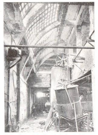
**Abb. 1** Zustand einer Eisenbetonkonstruktion, die infolge eines Brandes Temperaturen bis 1500 °C ausgesetzt wurde.
