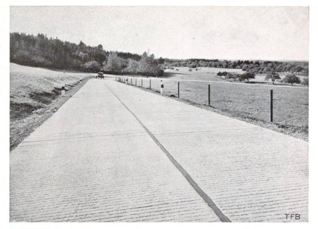
**Neukirch-Winden** (Kt. Thurgau), 19,466 m², erstellt 1933, 16 cm starker Betonbelag mit geriffelter Oberfläche. Steigung  $5.5\,$   $^{\circ}/_{\circ}$ ,
