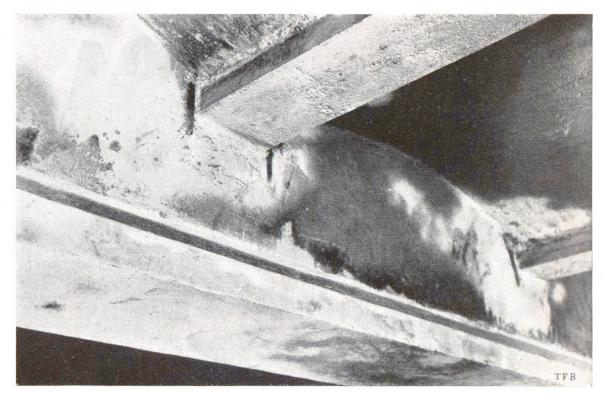
Abb. 4 Fertig gunitierte Quer- und Hauptträger
