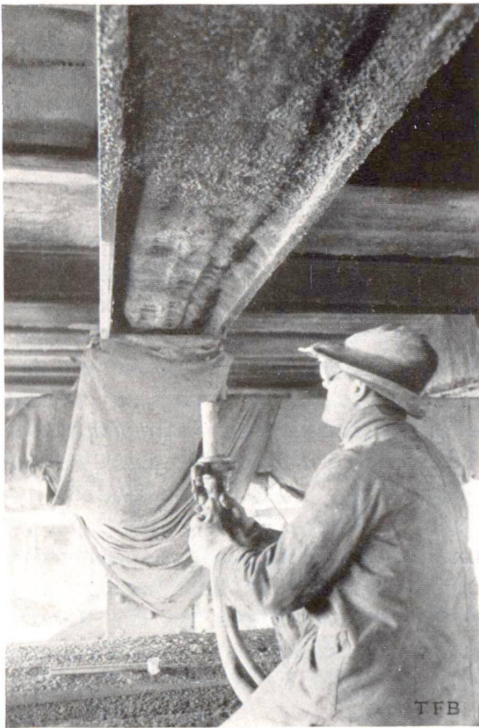
Abb. 3 Gunitieren der Untergurte
