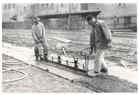
Abb. 1 Oberflächliche Vibration mit dem «Vibropil» - bei einer Betonstrasse im Güterbahnhof Zürich - Bauleitung: Betonstrassen A.-G., Wildegg; Unternehmung: Prader & Cie., A.-G., Zürich.
