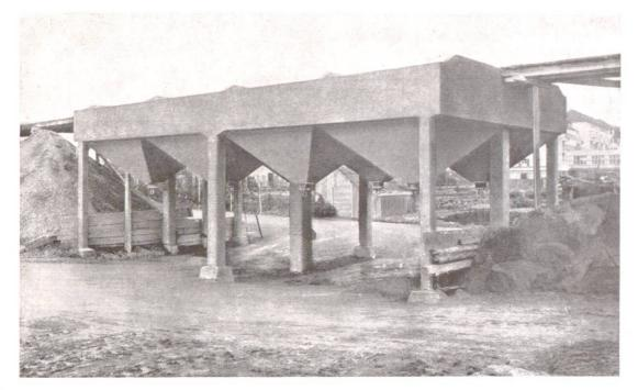
Abb. 4 **Kies-Silos der Oberhard A.-G. in Zürich**Projekt und Berechnung: Ingenieurbureau E. Rathgeb, Zürich
