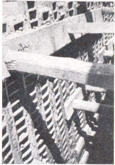
Abb. 6 Plankspundwand in der Seekreide des Bodenseeufers bis 12 m unter Terrain. (Projekt und Bauleitung Ingenieurbüro F. Boesch, Zürich)
