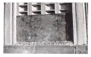
Abb. 3 **Wandisolation**Anordnung der isolierenden
