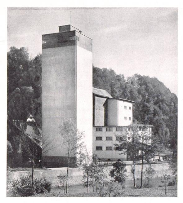
Abb. 3 **Walzmühle in Wolhusen** Eisenbetonsilo in Gleitschalung hergestellt. Höhe 28,5 m, Bauzeit 10 Tage.
