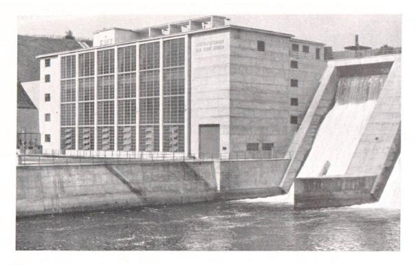
Abb. 2 Maschinenhaus des Kraftwerkes Wettingen in Sichtbeton
