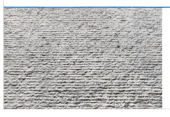
Die Oberfläche einer Betonstrasse in der Photographie: diese zeigt, dass, dank unseres Spezialverfahrens, ihre Oberfläche rauh u. doch eben wird: das macht die Betonstrasse griffig und gleitsicher-scharfheben sich nachts zudem die Hindernisse von ihr ab.
