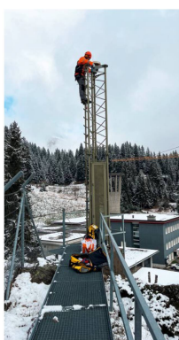
Figure 1: travaux de maintenance de l'antenne GNSS à la station AGNES OALP (Oberalppass)
