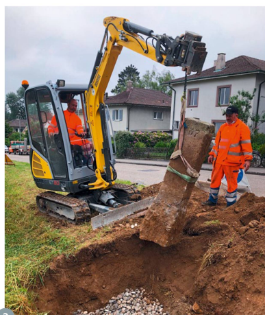
Figures 3 et 4 : une excavatrice soulève puis repose la borne pesant près de 400 kg – il faut s'y mettre à trois pour dresser la borne (© P. Reimann)
