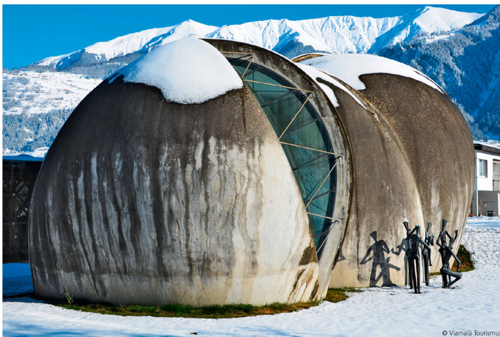
Les coques en béton de l'église de Cazis
