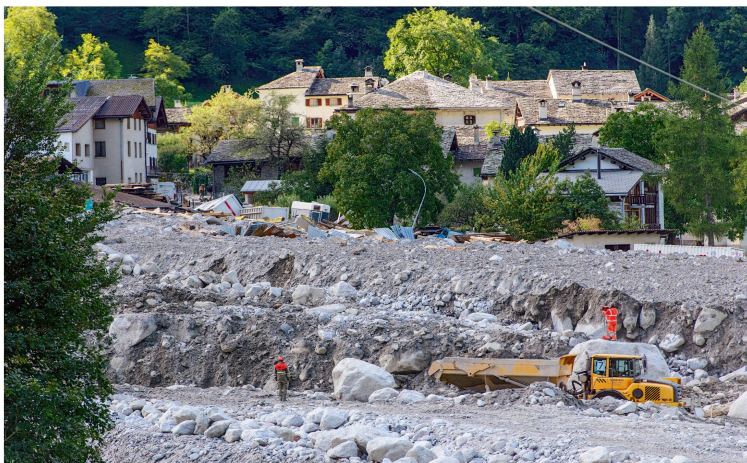
Figure 1: Bondo après les laves torrentielles de 2017 (© swisstopo)
