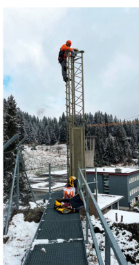
Abbildung 1: Wartungsarbeiten an der GNSS-Antenne der AGNES-Station OALP (Oberalppass)
