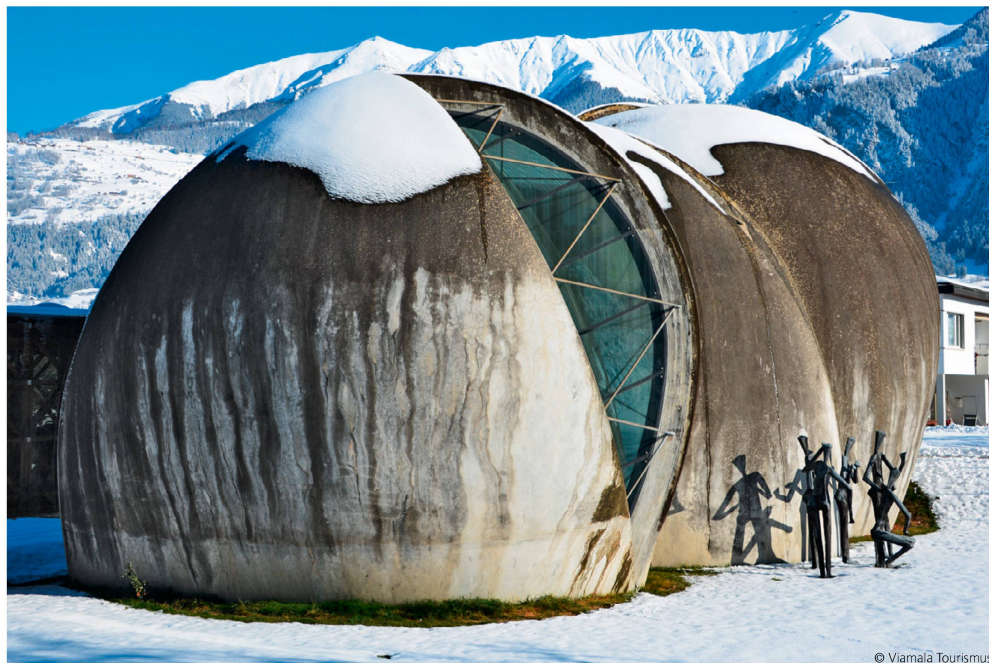
Schalenbau der Steinkirche in Cazis
