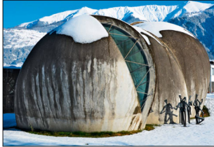
Schalenbau der Steinkirche in Cais (Quelle: graubuenden.ch)
