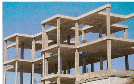
Abb. 8: Gemeinschaftliche Objekte – Die statischen Elemente eines Gebäudes (Bauteile) wie Stützen, Boden, Decke, Dach
