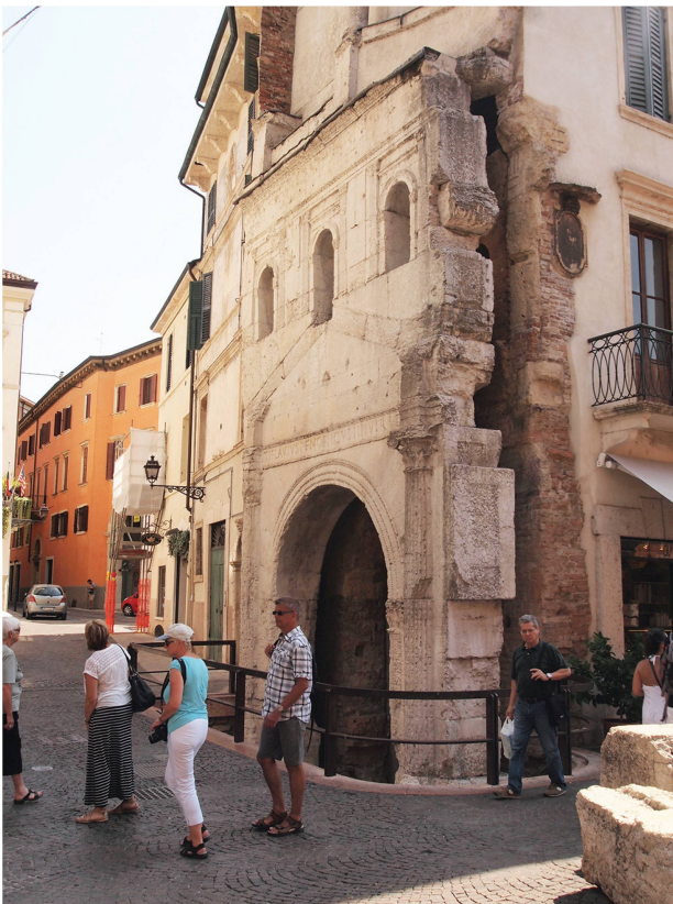
Abb. 3 Stadtseitige Fassade der Porta Leoni in Verona. In frühaugusteischer Zeit wurde der älteren Fassade aus Ziegelmauerwerk eine neue Fassade aus Kalkstein vorgeblendet (Foto M. Flück).
