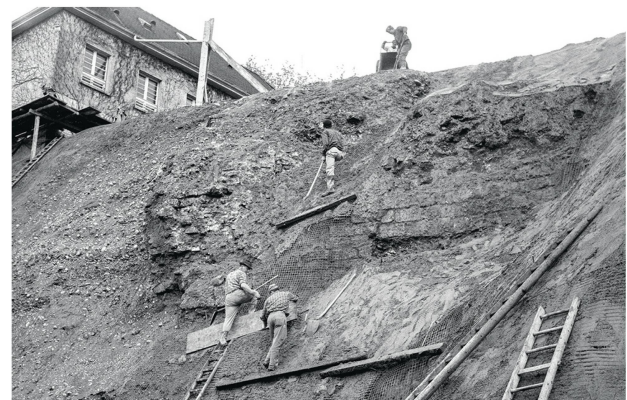
Abb. 26 Windisch-Nordwestturm 1965. Massives opus-caementitium-Fundament und Schalmauerwerk der nordwestlichen Lagerumwehrung fallen einem Neubau der Klinik Königsfelden zum Opfer (Kantonsarchäologie Aargau, Foto V.65.1 Nr. 3 und 8).
